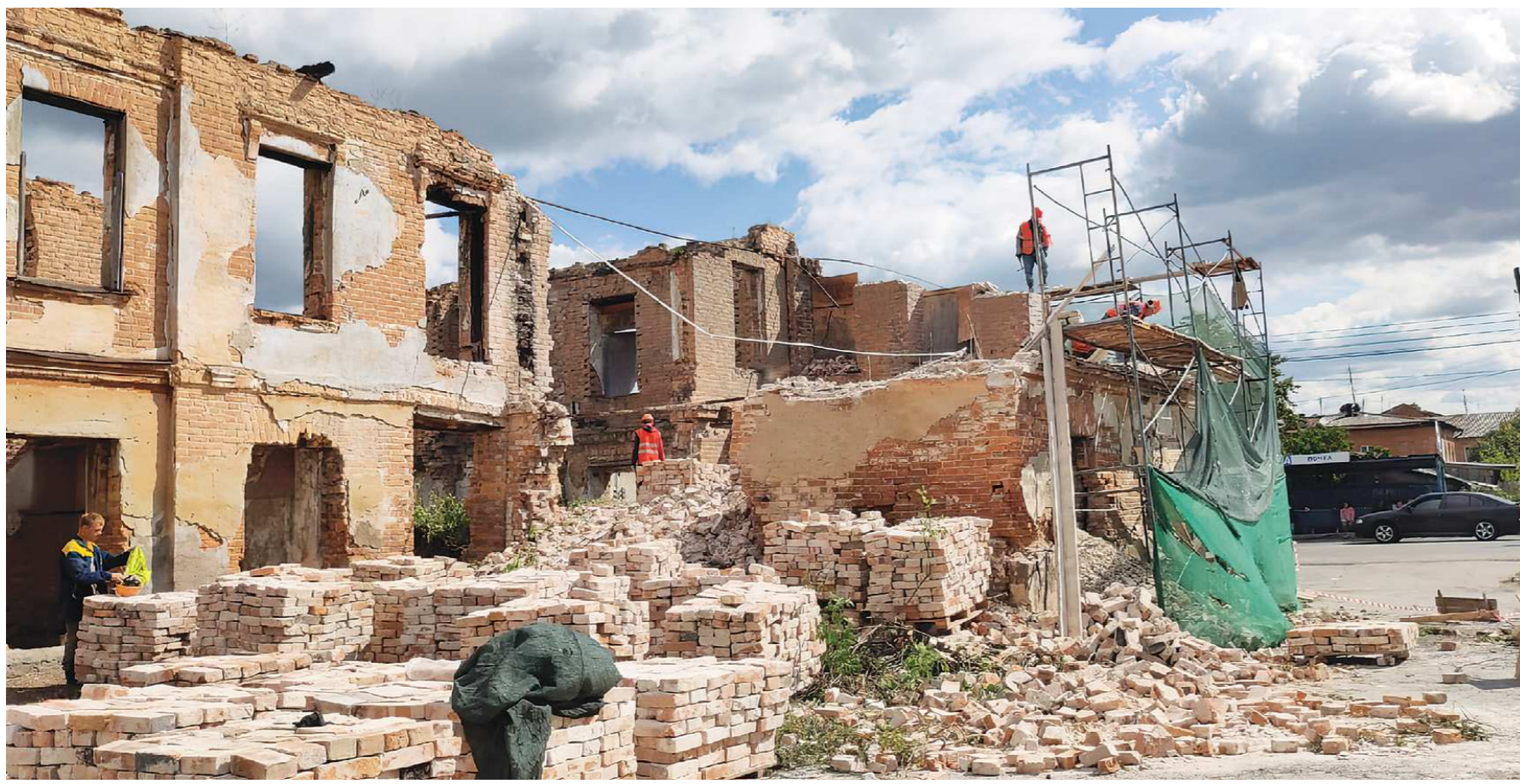
Дом №37 по улице Орджоникидзе, известный в Ирбите как «Дом Павлова»: подрядчики разбирают аварийные конструкции
