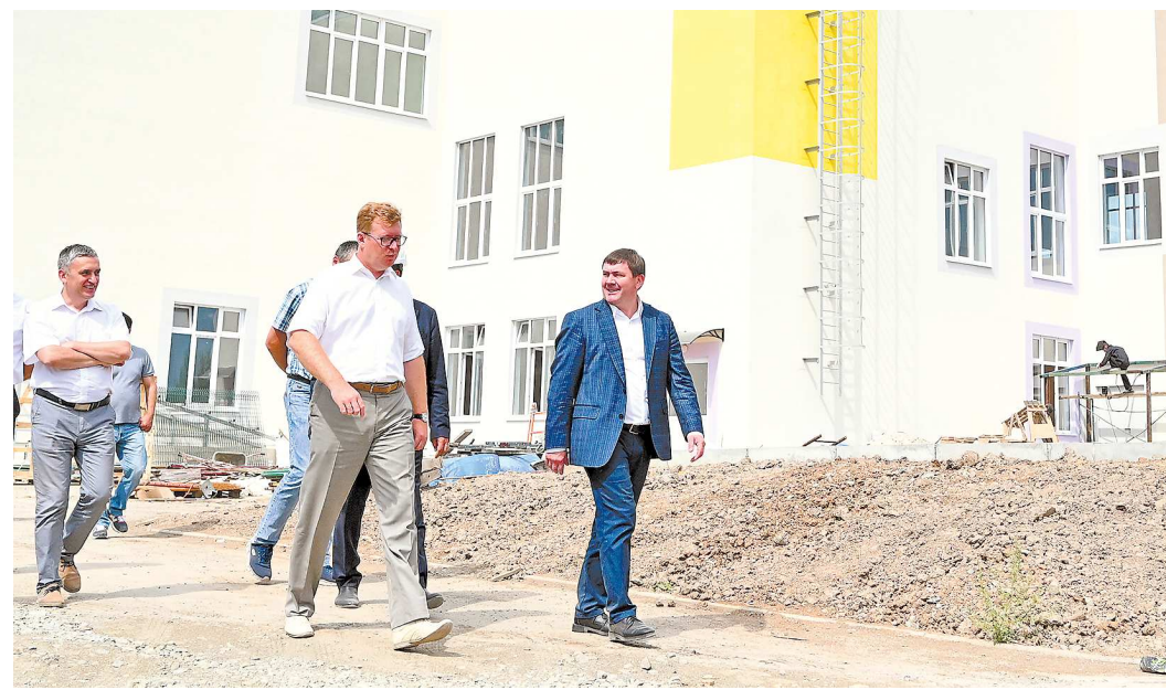
Первый заместитель губернатора Свердловской области Алексей Шмыков (справа) и глава ГО Первоуральска Игорь Кабеч (в центре) на осмотре новой школы в поселке Билимбай, которая откроется в День знаний
