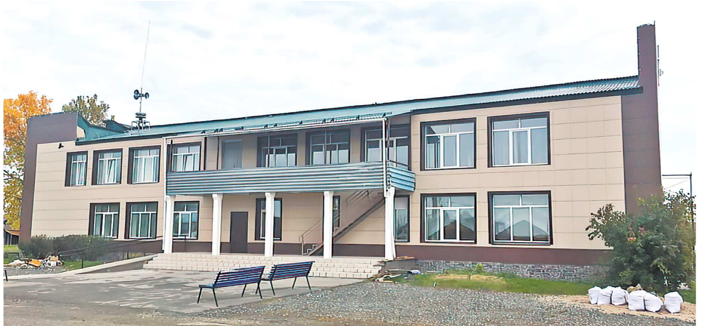
Дом культуры в селе Арамашево (Алапаевский район) был построен в 1969 году и 50 лет не ремонтировался. В 2019 году после капремонта он приобрел современный вид
