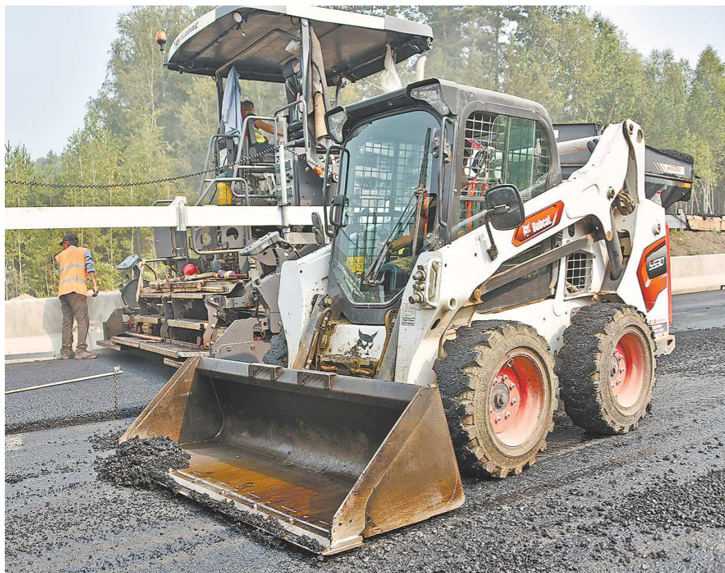
В верхний слой асфальтобетона добавлена полимерно-битумная вяжущая составляющая. Она противостоит образованию трещин
