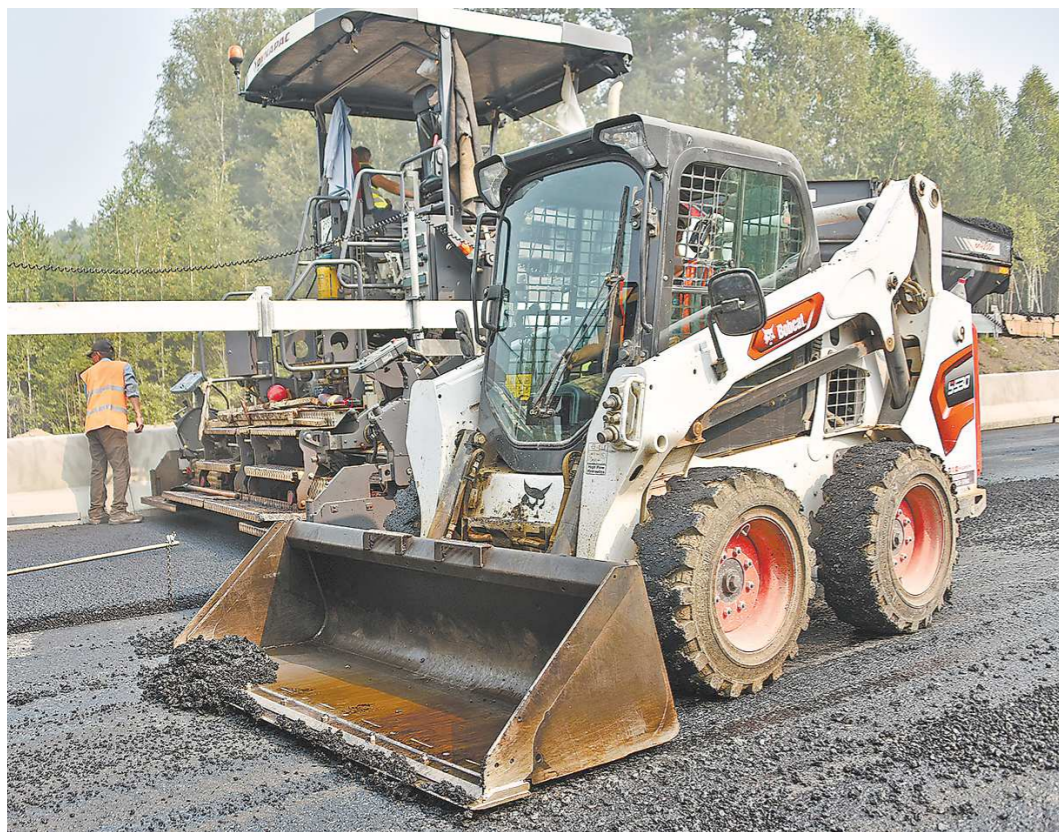
В верхний слой асфальтобетона добавлена полимерно-битумная вяжущая составляющая. Она противостоит образованию трещин
