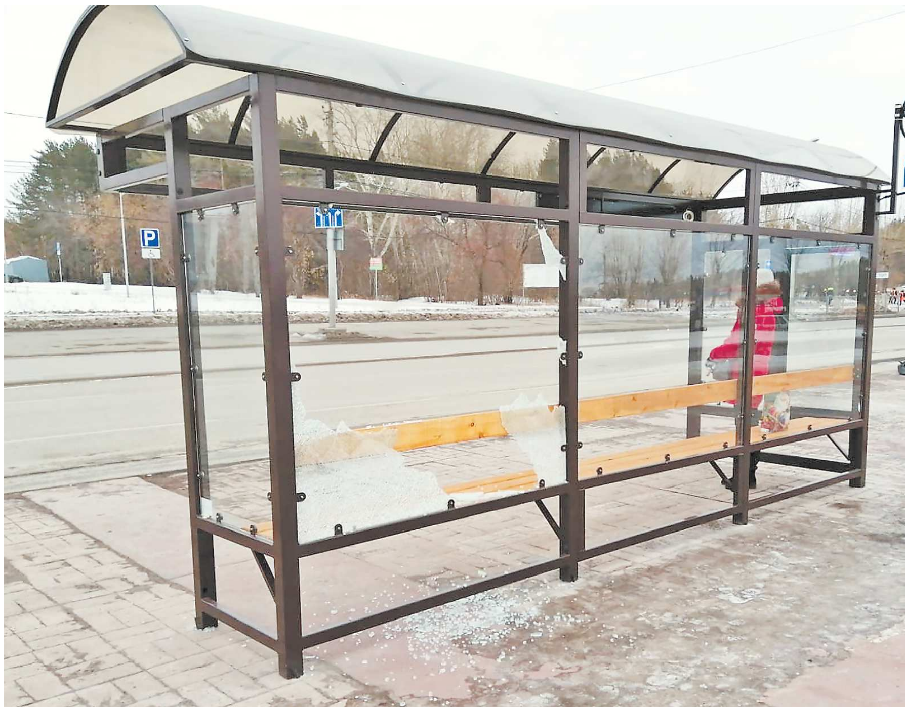
Закаленное стекло в четыре-пять раз прочнее, чем обычное, но от сильного целенаправленного удара тоже ломается, разбиваясь на мелкие осколки с тупыми краями
