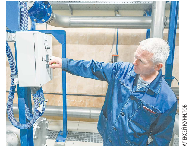
Для работы на обновленных очистных сотрудники пройдут дополнительное обучение у специалистов, которые устанавливали оборудование
