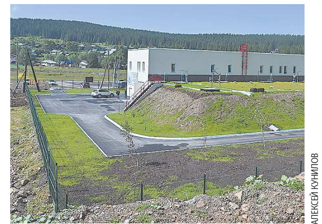
Сооружение возводили по венгерским технологиям, на основании опыта работы будапештского Водоканала
