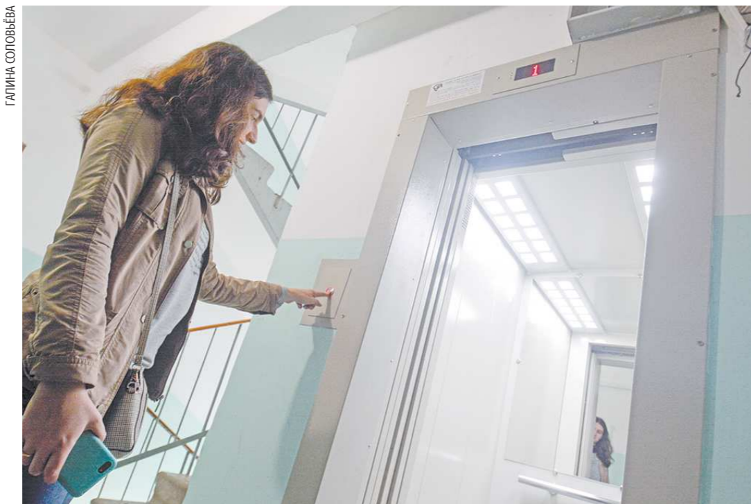
Лифты в многоквартирных домах едут со скоростью 4 метра в секунду, раскачивать кабину лифта или прыгать в ней запрещено
