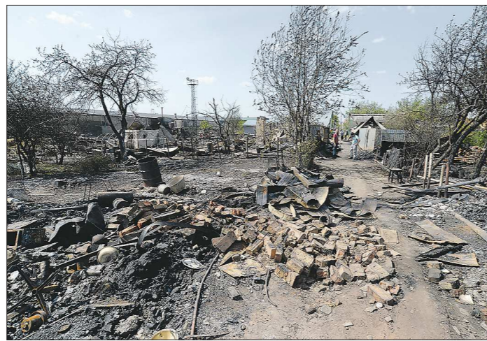
Местами огонь дотла выжег дома в садоводческом товариществе «Горноспасатель»
