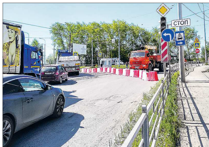
В связи с ремонтом моста установлено 187 знаков, указывающих объездные пути
