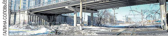
По путепроводу на улице Блюхера ежедневно из дома на работу ездят тысячи жителей Берёзовского и соседних населённых пунктов
