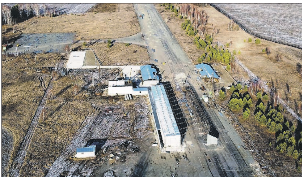
Ангары устанавливаются прямо на бетонном покрытии бывшей взлётно-посадочной полосы, это бытовки-временники
