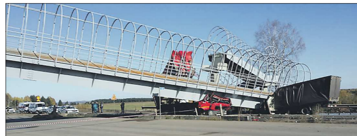
Вчерашнее обрушение перехода парализовало движение по трассе Р-242 Пермь – Екатеринбург, движение временно организовано в объезд
