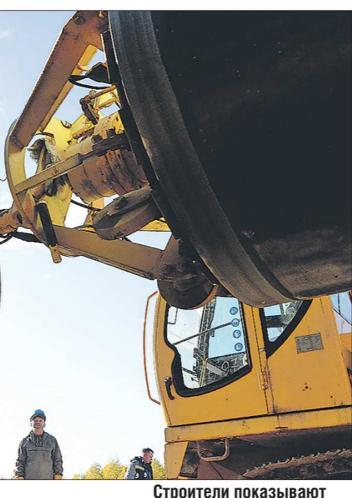
Строители показывают процесс сборки труб нового участка нефтепровода Бургут - Полоцк
