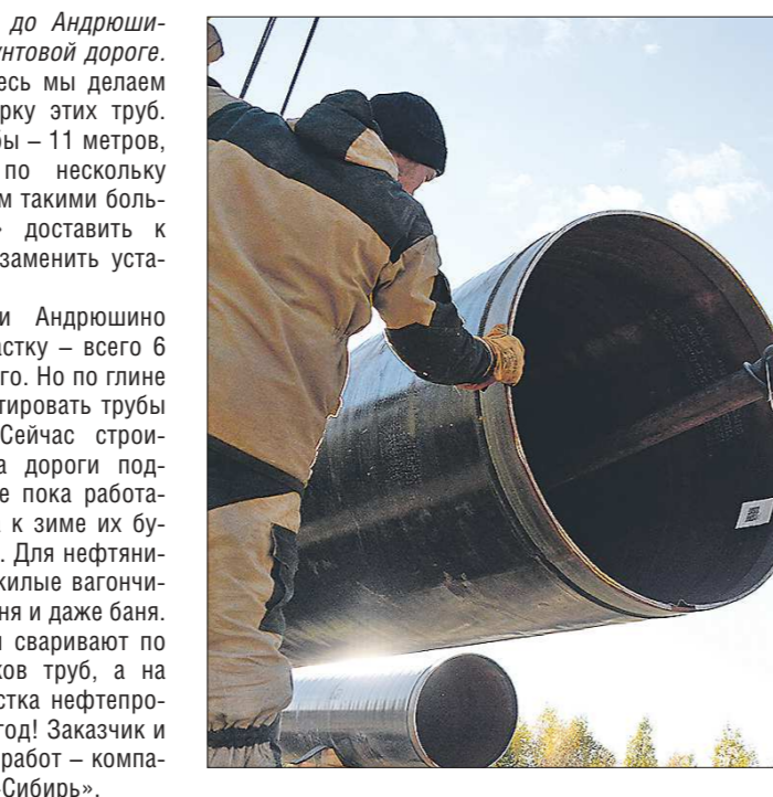
Строители показывают процесс сборки труб нового участка нефтепровода Бургут - Полоцк
