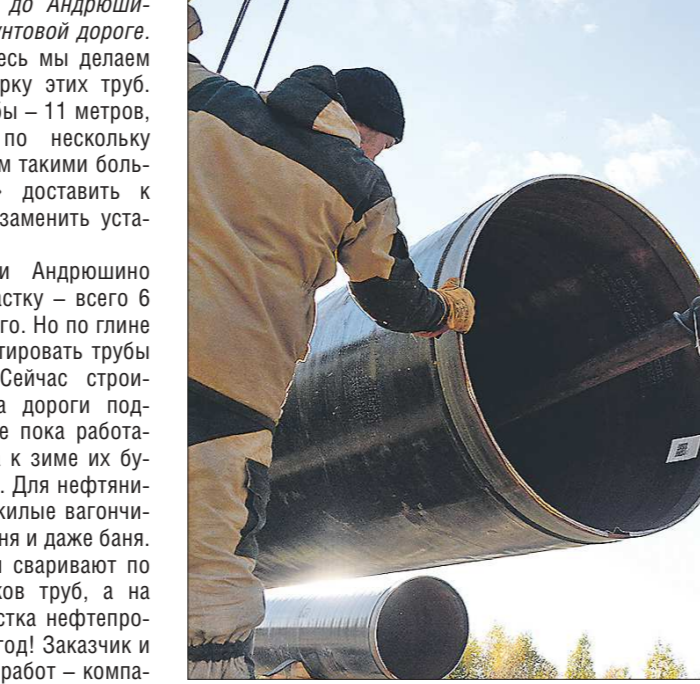
Строители показывают процесс сборки труб нового участка нефтепровода Бургут - Полоцк
