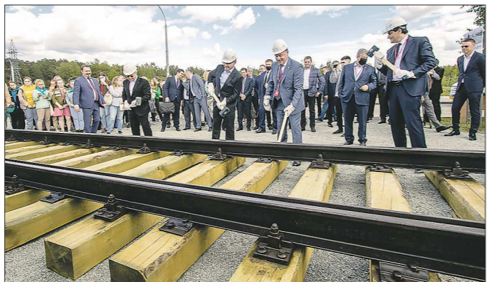
Закладка символических рельсов для трамвая в Академический проходит с участием главы Минстроя РФ Ирека Файзуллина и других высокопоставленных лиц
