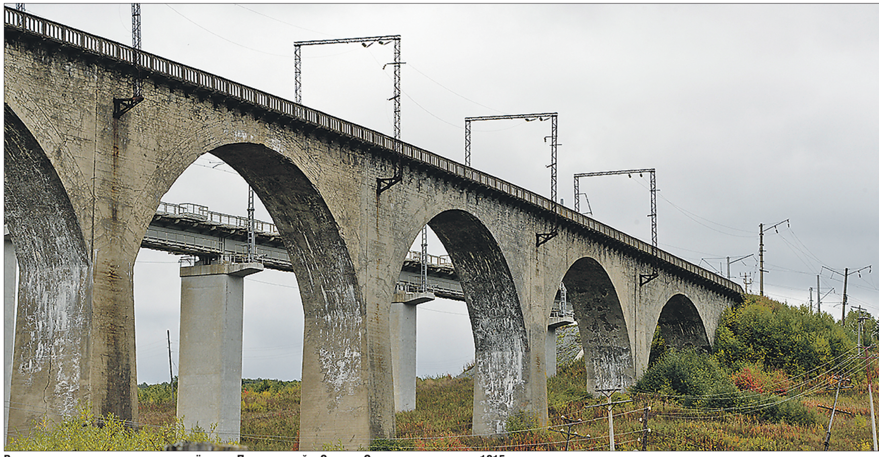
Вот так выглядят виадук между посёлками Пудлинговский и Сарана. Он начал строиться в 1915 году
