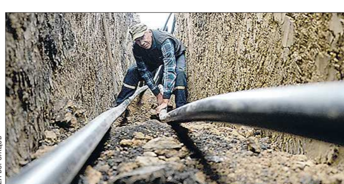
Новые полимерные трубы монтируются быстро
