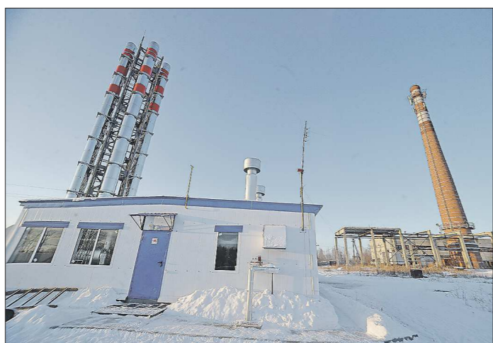
Волчанск. В котельной в Волчанске две газовые котельные позволили уйти от издержек по эксплуатации огромной старой котельной, которая обслуживала не только жилой фонд, но и ныне неработающее предприятие по добыче угля
