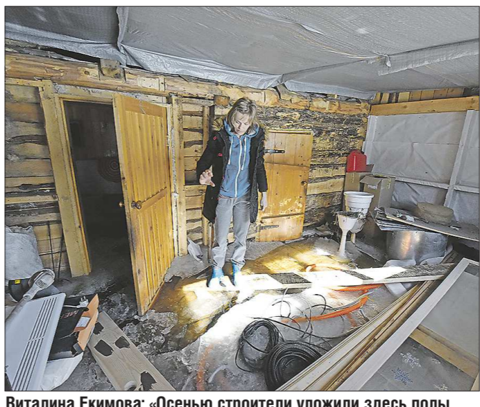
Виталина Екимова: «Осенью строители уложили здесь полы, теперь придётся их вскрывать и просушивать»
