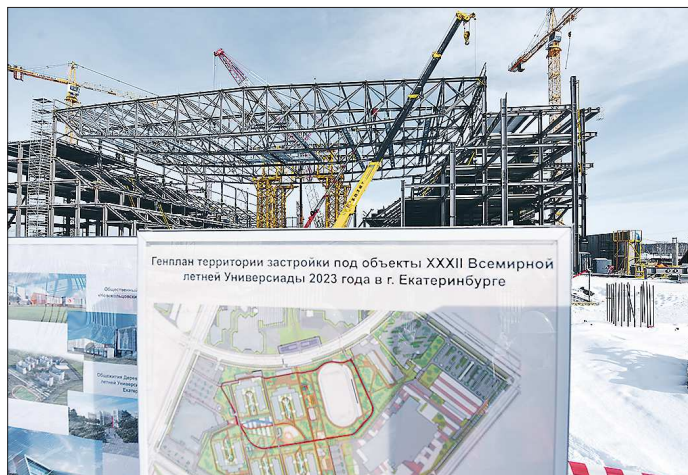
Для строительства дворца завезена половина металлоконструкций - 4900 тонн, из них 2500 уже смонтировали
