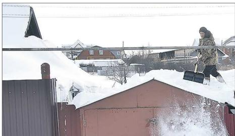
Сбрасывать снег нужно и с гаражей, иначе крыша может прогнуться под его тяжестью
