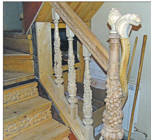
Лестница, ведущая на второй этаж, разительно отличается от среднестатистических лестниц
