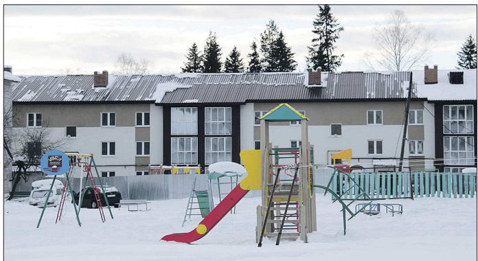
Новый дом по улице Тимирязева в посёлке Чащавита. Такие стройки разворачивались, пожалуй, только в советское время
