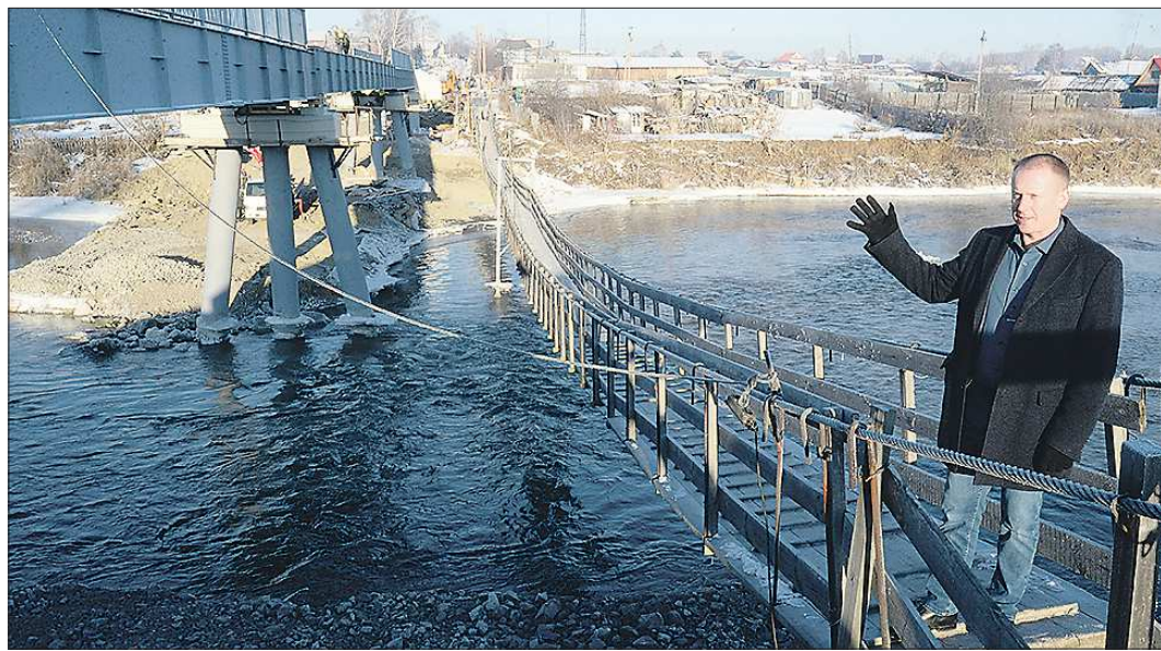
Сергей Белоусов стоит на старом, деревянном мосту между двумя сёлами. Рядом — новый мост из металла, который сейчас достраивается
