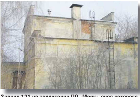
Здание 121 на территории ПО «Маяк», снос которого предполагается в рамках программы ликвидации накопленного ядерного наследия
