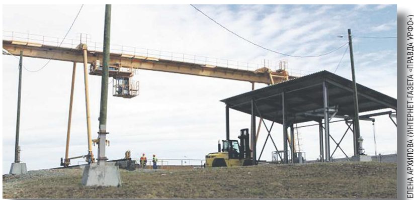
В этом году на ликвидацию зараженных зданий и сооружений заложили более 600 млн рублей
