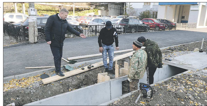
Мэр города проверяет ремонтные работы на улице Ленина
