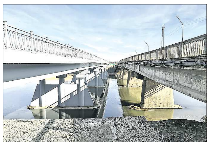
Длина мостовых конструкций в Красноуфимске – 174 метра
