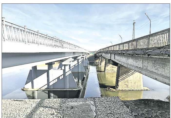
Длина мостовых конструкций в Красноуфимске – 174 метра
