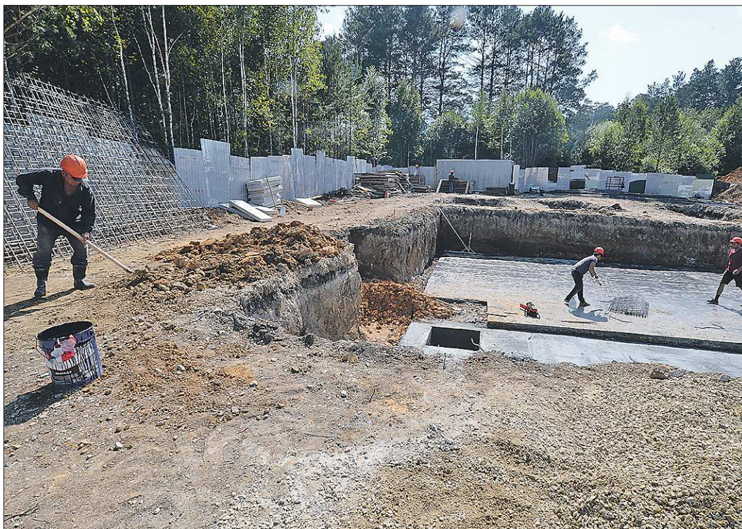
Сейчас на стройплощадке идёт гидроизоляция фундамента нового центра
