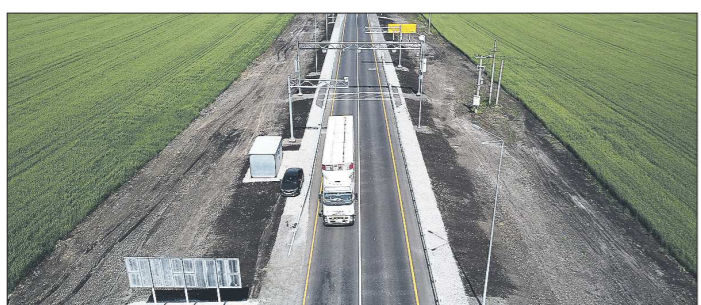
Вмонтированные в дорожное покрытие датчики взвешивают автомобили в движении и при перегрузе сообщают сведения о нём в ГИБДД
