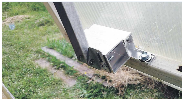
Чтобы установить проветриватель в металлическую раму деревянной теплицы, приходится наращивать из обрезков алюминиевого профиля место крепления автомата
