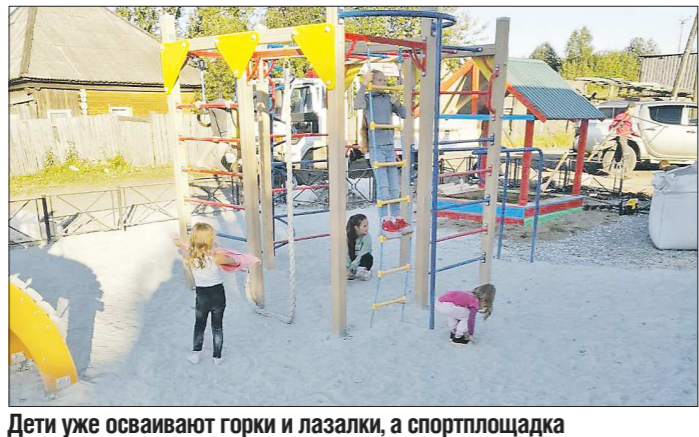
Дети уже осваивают горки и лазалки, а спортплощадка ещё строится
