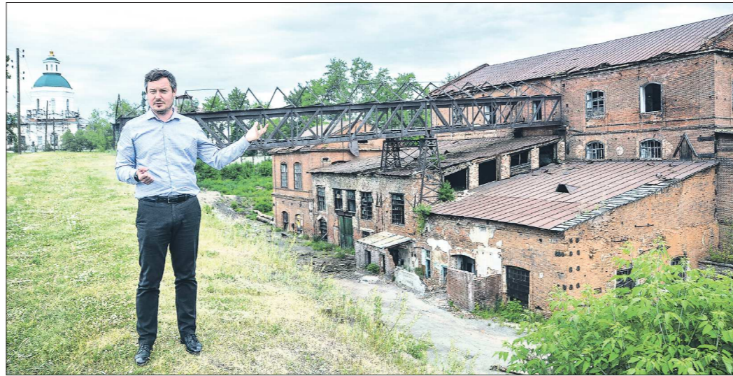
Год назад Дмитрий Нисковских делился планами о том, как преобразится территория завода. Реконструкция ещё впереди, но первые мероприятия пройдут уже летом
