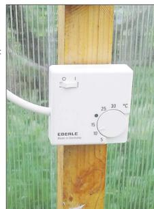
Терморегулятор должен быть установлен на уровне растений и не ближе полуметра от электронагревателя
