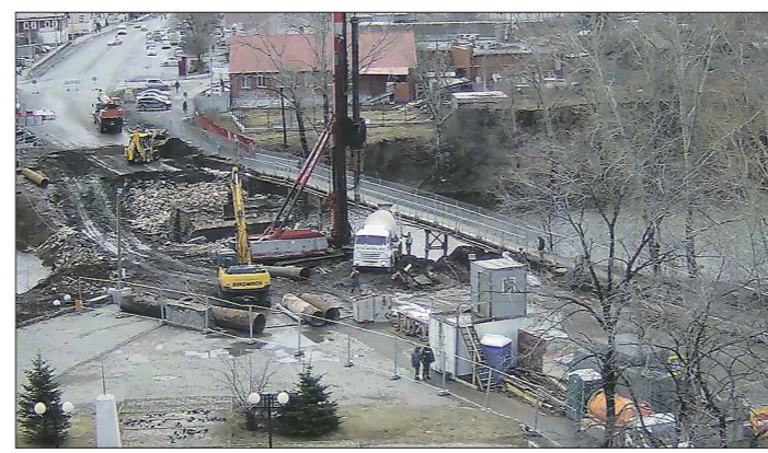
Так выглядит реконструкция моста с высоты птичьего полёта
