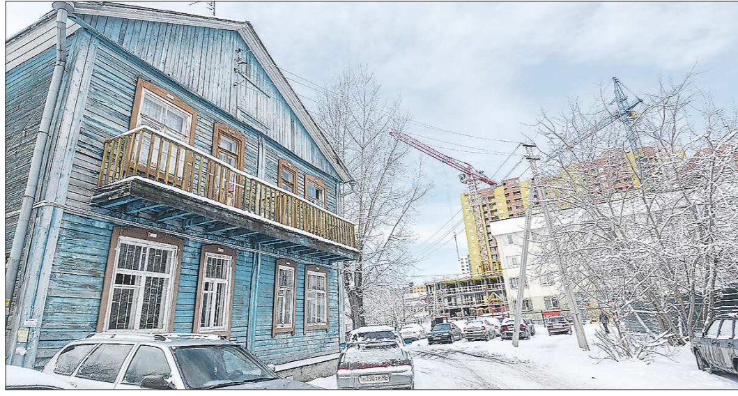
В ста метрах от дома на ул. 40-летия Октября, 39 идёт строительство ЖК «Мир.Труд.Май», который возводит ООО «Милстрит»
