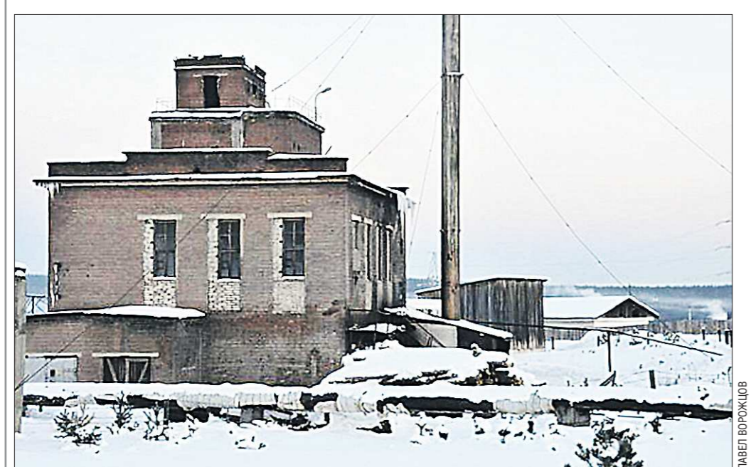
Котельные многих предприятий снабжают горячей водой и теплом не только производство, но и жилые дома
