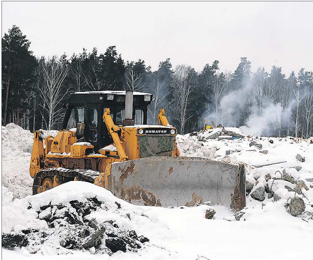
Снег поверх отходов равняют грейдером
