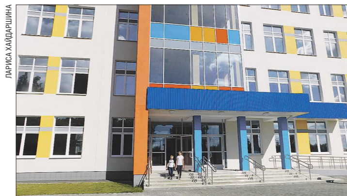
Новое здание школы в Кировграде на 1200 мест
