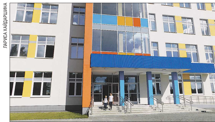
Новое здание школы в Кировграде на 1200 мест
