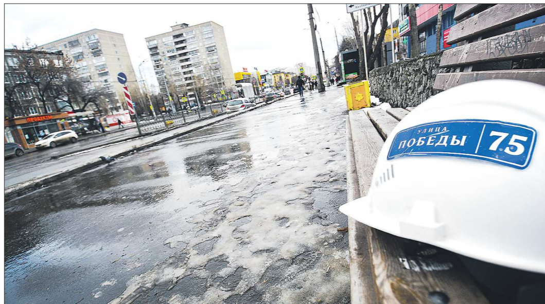
В Екатеринбурге улица Победы находится на Уралмаше. И в этом году она уже частично перекрывалась для ремонта трамвайных путей
