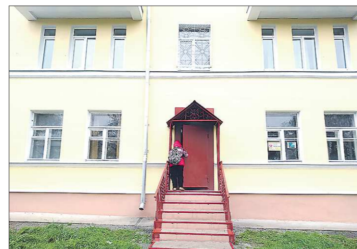
Капремонт подарил дому новую жизнь
