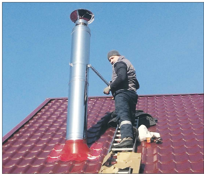
Для автоматического котла необходимо смонтировать дымоход
