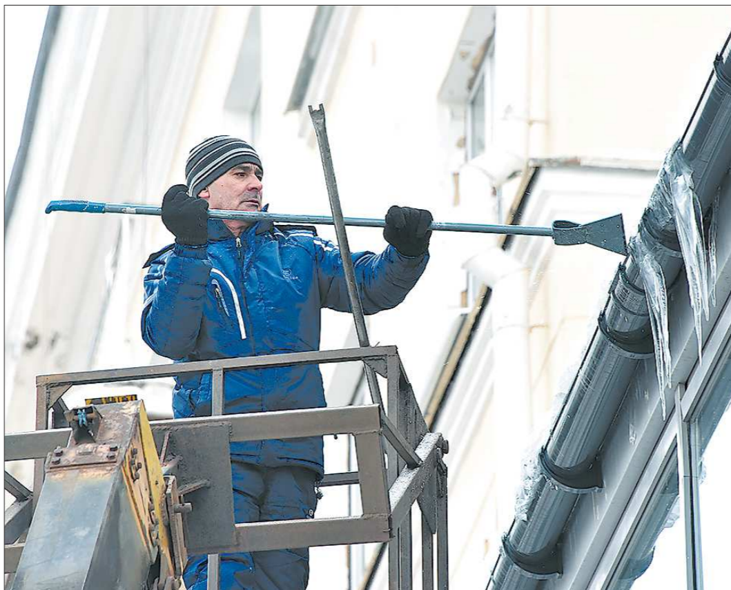
Снег с крыши убирают, если его высота превышает 30 сантиметров. В экстренных случаях приходится сбивать наледь уже с края кровли
