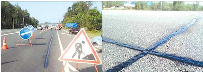
Битумно-полимерная лента, предназначенная для санации трещин асфальтобетонного покрытия
