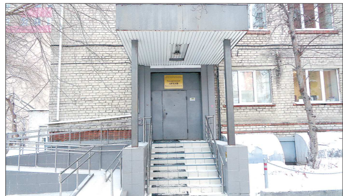
Госархив Свердловской области находится в специальном здании для хранения документов
