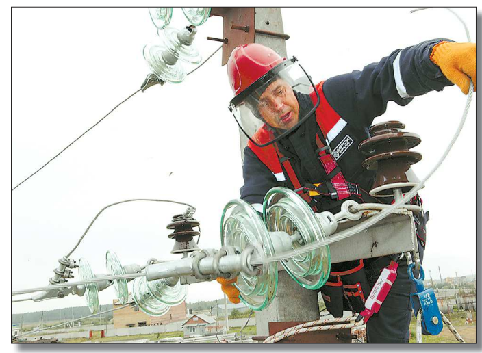
Ремонтные работы в электросетевом комплексе филиала «Свердловэнерго»
