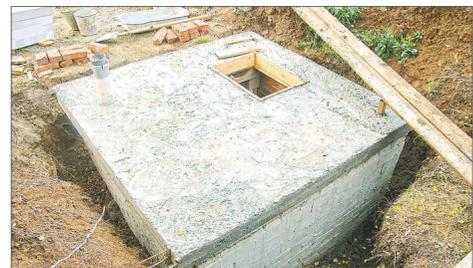
Примерно так может выглядеть отдельно стоящий погреб. Здесь грамотно установлены трубы вентиляции – они стоят в разных углах
