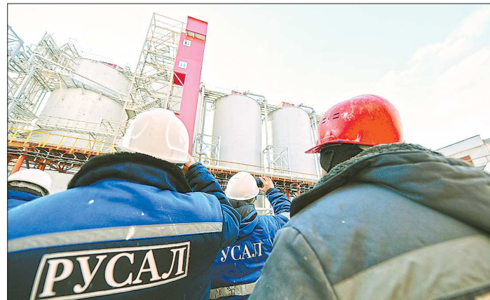
Обновлённый участок декомпозиции представляет собой батарею из шести декомпозиров - аппаратов для разложения алюминиевого раствора
